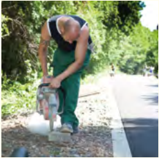
Arbeiten an der Nordbahntrasse
