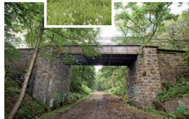
Die Trasse unter einer Brücke zwischen Bracken und Tunnel Schee im Naturschutzgebiet
