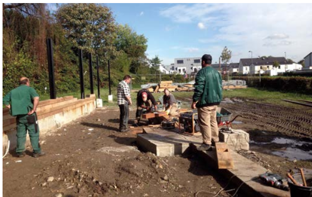
Nach dem Einbau der Drainagerohre wurden mehrere Sattelschlepper Erde gebraucht, um den Boden zu ebnen
